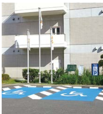
◀屋根のない障がい者用駐車場
